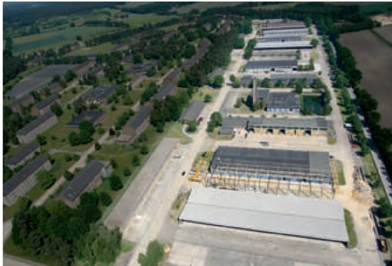
Im Frühjahr 2009 übernahm Krampe Fahrzeugbau den Instandsetzungsbereich der ehemaligen Kaserne Coesfeld-Flamschen. Auf 100.000 m 2 – davon derzeit 28.000 m 2 überdacht – entstand eine moderne und flexible Fertigung.
